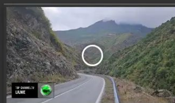
Top Channel/ Dëborë në malet e Tropojës, shiu sjell gurë e dhera në disa rrugë të Kukësit 26/09 12:18
