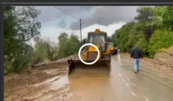
Top News – Moti i keq shkatërron Kretën. Makina në det, shtëpi të përmbytura dhe rrugë të dëmtuara 03/10 21:30
