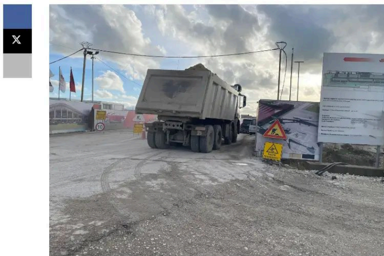
Kantieri i ndërtimit të aeroportit të Vlorës. Foto: Vladimir Karaj.
